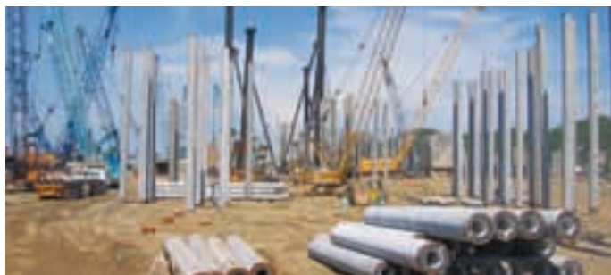
澳門「星麗門」地基工程。 Foundation works for Studio City, Macau.
