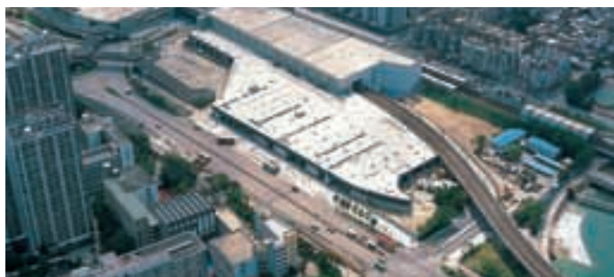
港鐵大圍站公共交通工具交匯處地基工程。 Public transport interchange for MTRC Tai Wai Station.
