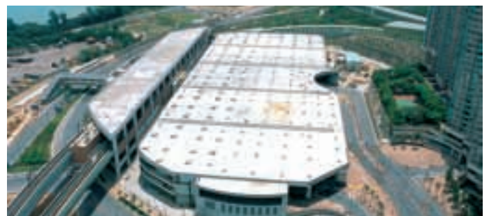
港鐵烏溪沙站公共交通工具交匯處地基工程。 Public transport interchange for MTRC Wu Kai Sha Station.
