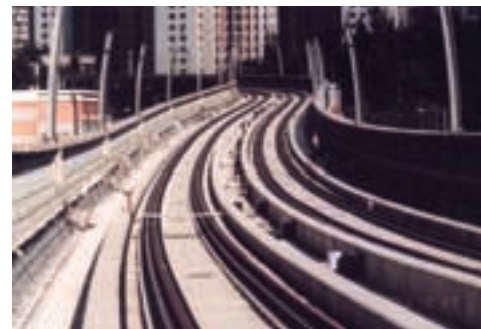
高架橋上已完成的軌道 Completed track on viaduct
