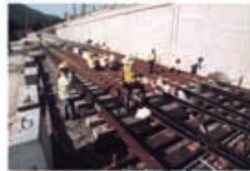
車廠道碴橫渡線在建造中 Depot crossover under construction
