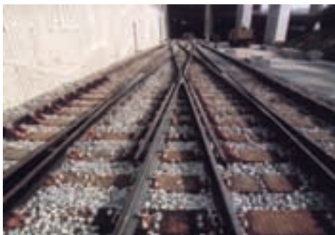
已完成之車廠道碴橫渡線 Depot crossover on ballast
