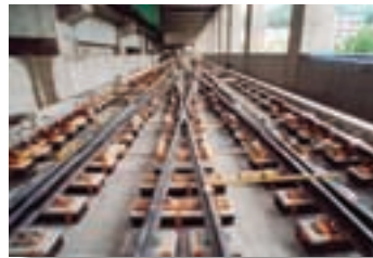
馬鞍山支線 - 大圍橫渡線在建造中 Ma On Shan Rail — Tai Wai Crossover
