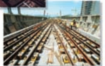
馬鞍山支線 - 烏溪沙橫渡線在建造中 Ma On Shan Rail — Wu Kai Sha Crossover
