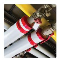
Le calorifugeage est une opération consistant à isoler les réseaux de tuyauterie de chauffage, qui acheminent l'eau chaude depuis la chaudière collective vers les appartements d'un immeuble. Mal isolées, ces canalisations entraînent des déperditions de chaleur, sources de gaspillage d'énergie. En effet, l'eau chaude baisse en température jusqu'à son arrivée dans les radiateurs ou aux robinets. Conséquence directe : les occupants doivent surchauffer pour obtenir un confort satisfaisant.
