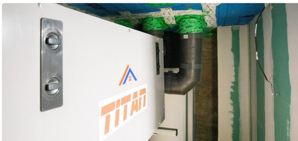
Installation d'un système de ventilation double flux pour un confort thermique et une qualité de l'air améliorés
