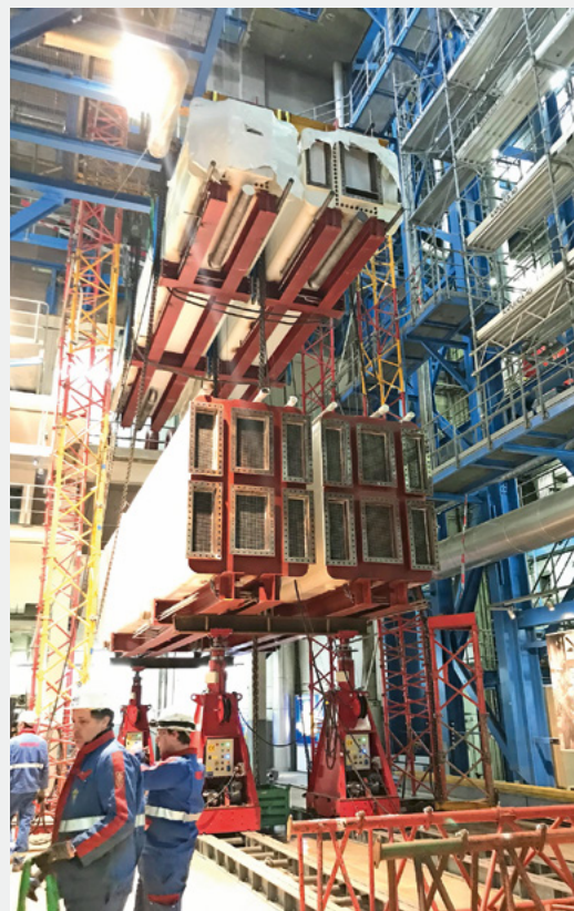
Fig. 12 Register der Wärmepumpe werden für die Montage aufgehängt.
