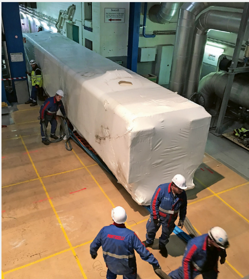
Fig. 10 Einbringung der Wärmepumpe mit Schwerlast-Luftkissen.
