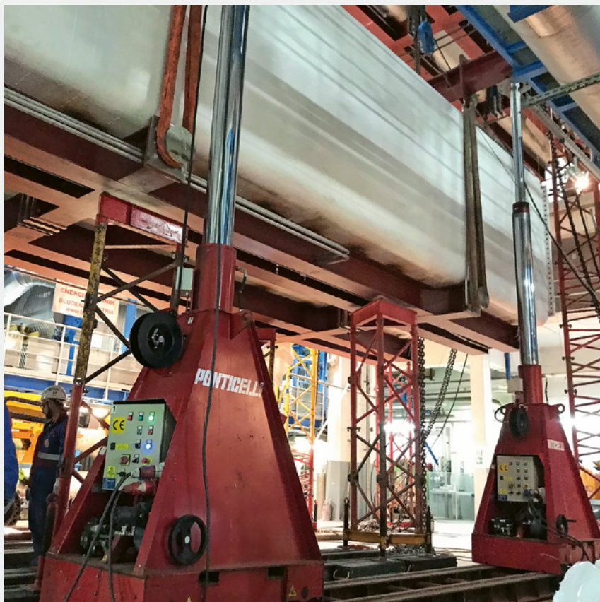
Fig. 11 Einbringung der Wärmepumpe mit Schwerlast-Hubsystem.
