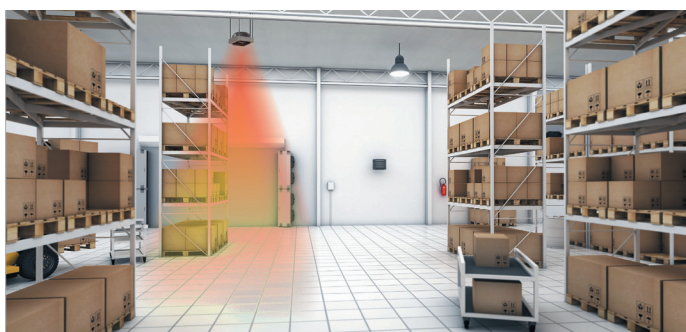
Fase1 - attivazione di destratificatori per spingere verso il basso l'aria calda recuperata dall'area sotto il soffitto
