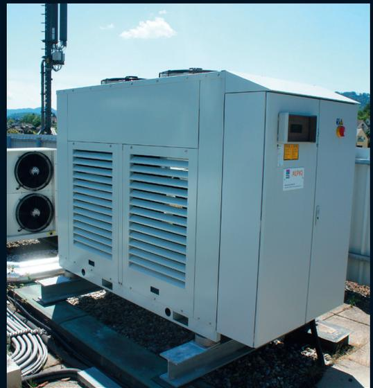
Un refroidisseur d'eau au toit du bâtiment supporte le travail des LCPs. Les caractéristiques avec impact sur la sécurité : des pompes, des compresseurs ou des réserves tampon redondants à variation de fréquence.
