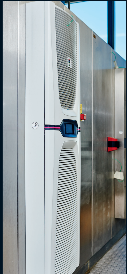
La dernière génération des climatiseurs muraux Blue e+ disposent d'une „heat pipe“ évacuant de façon passive la chaleur de l'intérieur de l'armoire.
