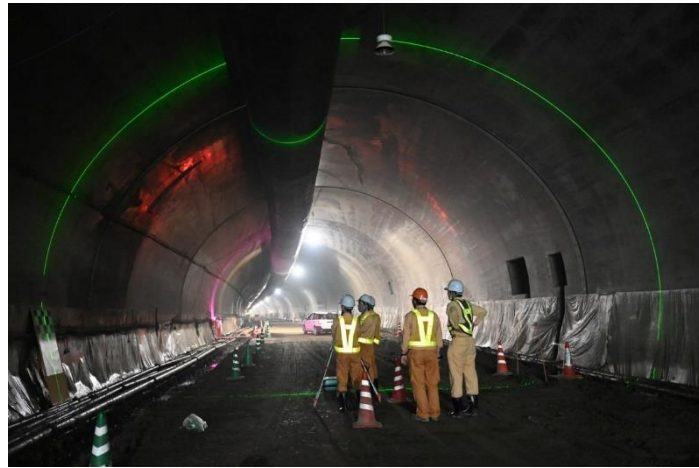
写真2 光切断法を用いたトンネル内での計測風景
