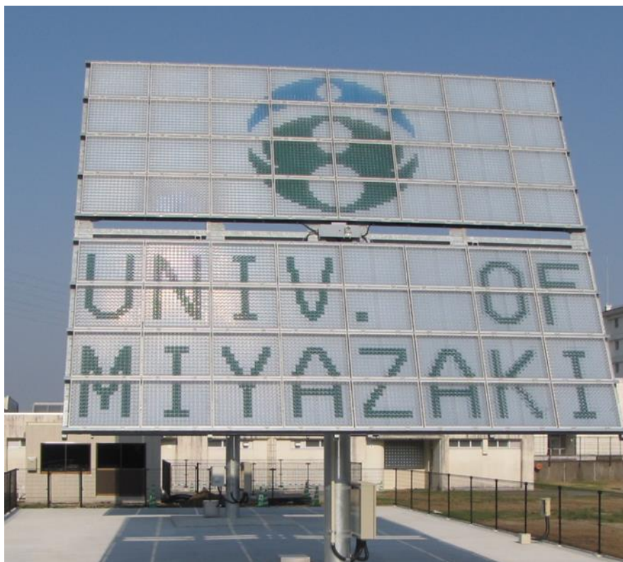
図 2 (b) 宮崎大学に設置された集光型太陽電池
