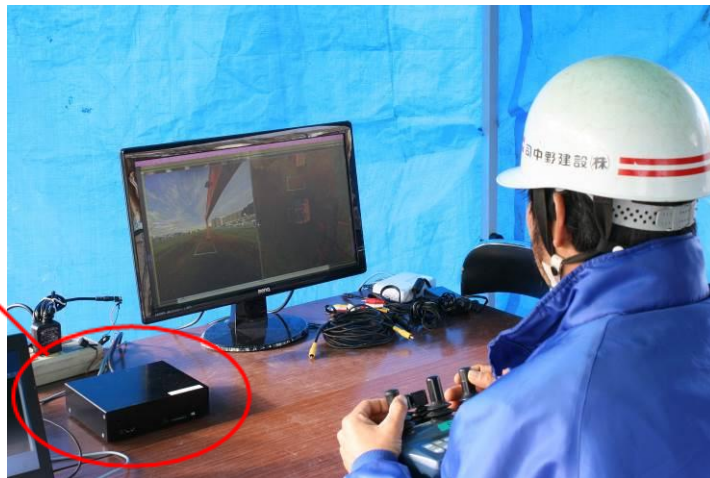
写真3 オペレーターによる遠隔操作状況
