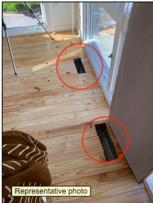
23. Loose/Missing register or grille
