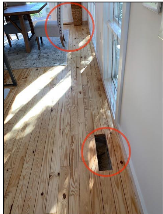
24. Loose/Missing register or grille
